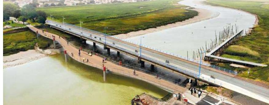
Construite en 1909, la passerelle piétonne qui permet de traverser le Lay à L'Aiguillon-la-Presqu'île va être détruite et reconstruite. Après avoir subi les attaques des éléments, et surtout du sel, il est aujourd'hui impossible de réparer ce « petit pont ». C'est le Département de la Vendée qui a été désigné maître d'ouvrage et qui assurera donc la démolition de l'ancienne passerelle et la construction de la nouvelle.
